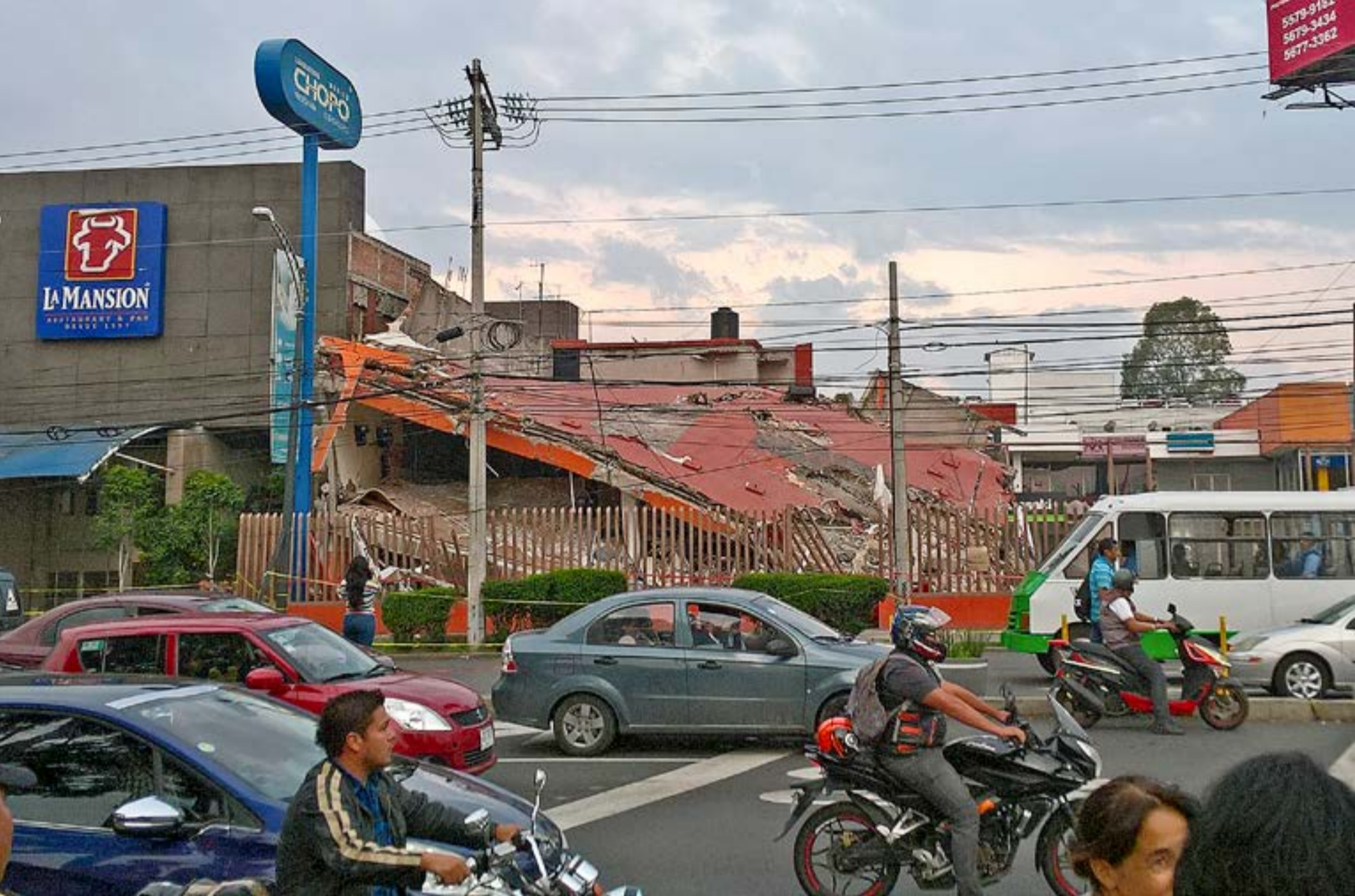
Edifici esfondrat al barri de Coapa, Tlalpan (sud de Ciutat de Mèxic) / ALBERT PORTILLO
