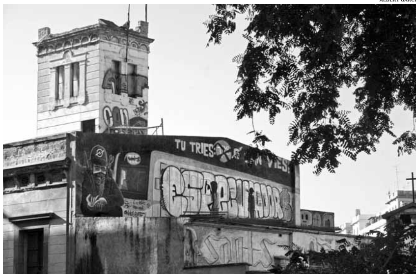
Façana de Can Vies
