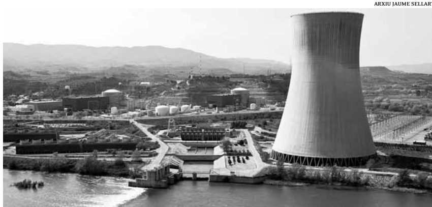
Reactor de la central nuclear d'Ascó
