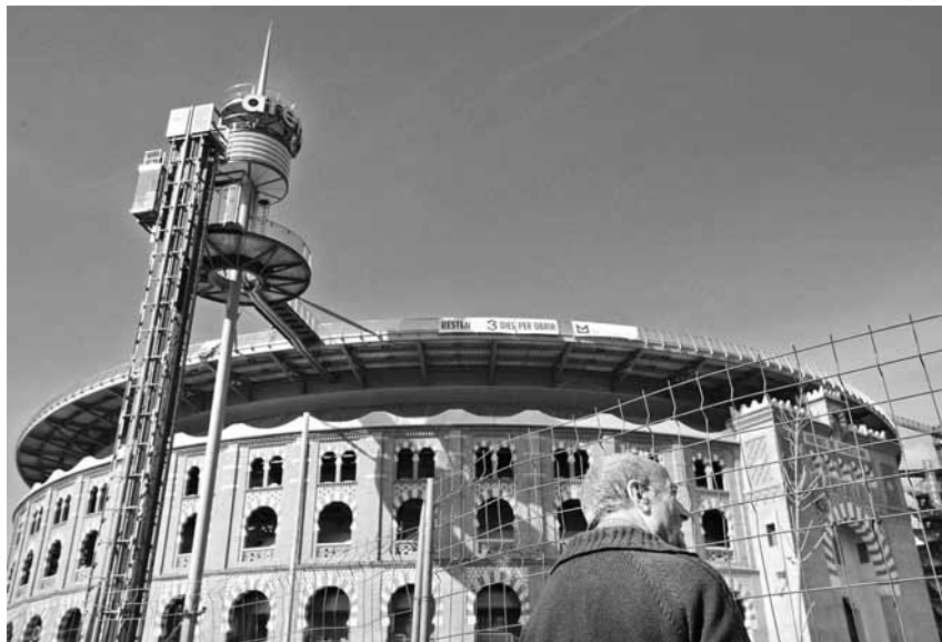
Un home observa les darreres feines de construcció a les proximitats del centre comercial que s'inaugurarà el 25 de març
