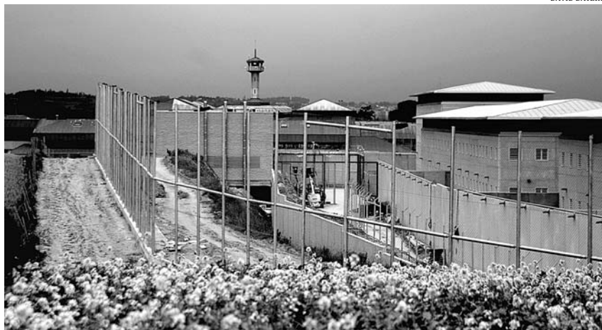
Presó de Quatre Camins, situada a La Roca del Vallès
