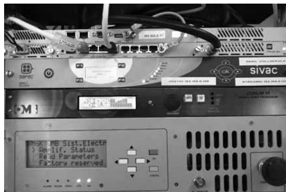
Detall de l'equip que Amb2 FM utilitza per emetre des de la torre de Collserola
