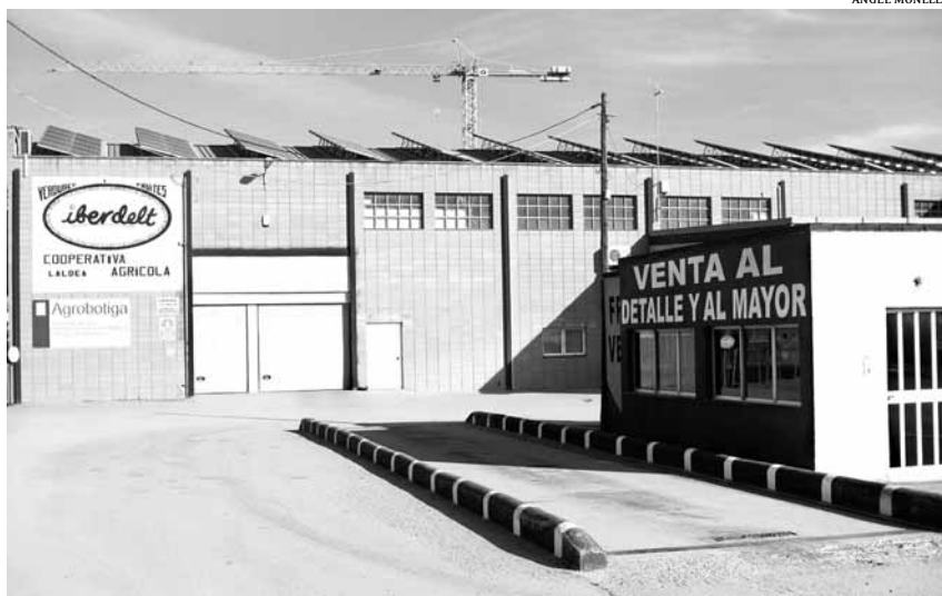
Edifici de la cooperativa de l'Aldea
