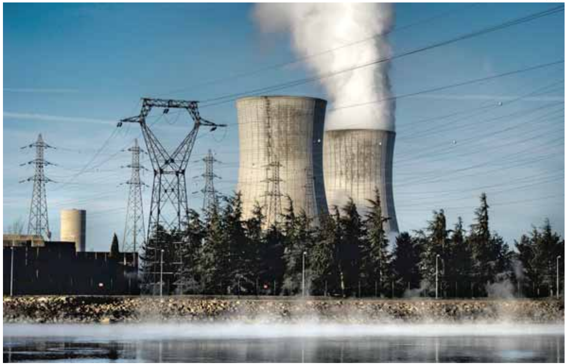
El mes de juliol, a la central nuclear francesa de Tricastin, hi va haver una fuga de 30 metres cúbics d'efluents radioactius que va afectar els aqüífers de la conca del riu
