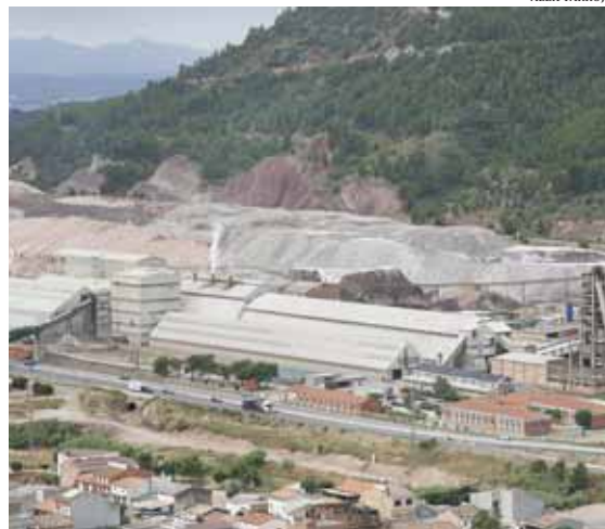
Panoràmica de les instal·lacions d'Iberpotash a Sallent
