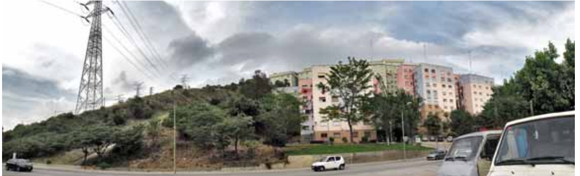
Red Eléctrica Española projecta una subestació elèctrica de Molt Alta Tensió en un espai catalanès com a zona verda protegida a Santa Coloma de Gramenet
