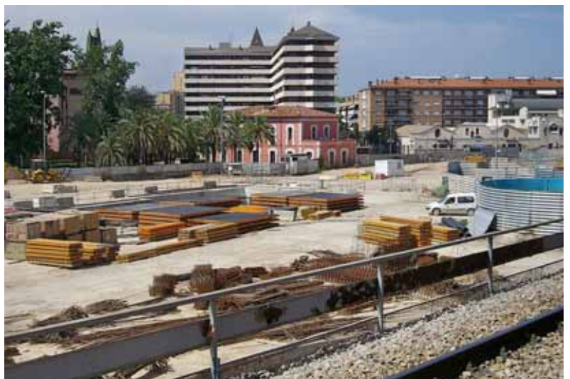
Obres del TAV al barri gironí de Sant Narcís / ADIF
