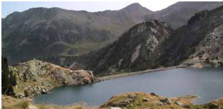
Vista de la presa Major de Colomers, amb una capacitat de 2,3 Hm 3 i una alçada de 25 metres / MARIA ORTUÑO
