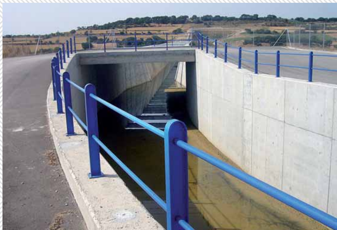
La Plataforma en Defensa de l'Ebre va denunciar un sobrecost del 81% en l'execució de les obres del canal / JORDI FERRER
