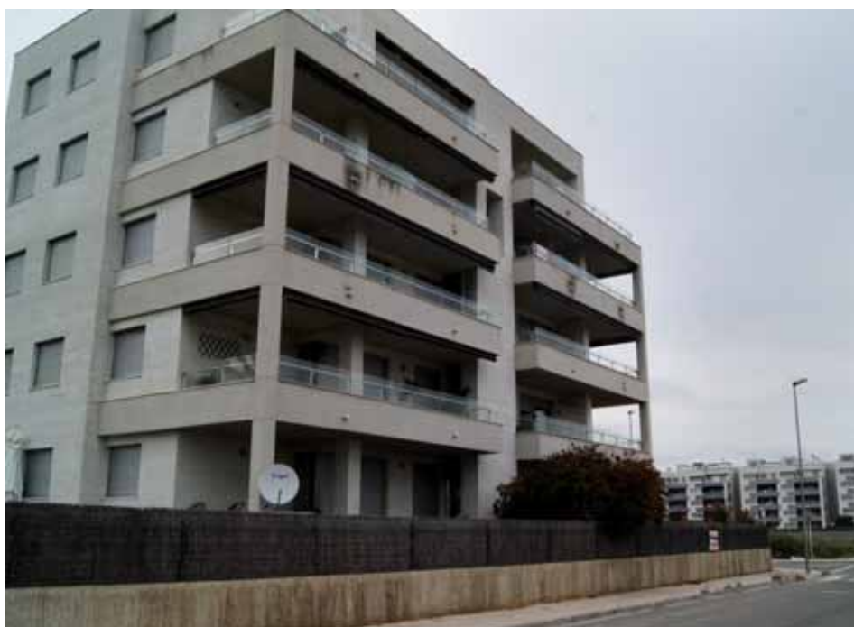
Un dels edificis de la urbanització Muntanyans II / MARTA ALONSO
