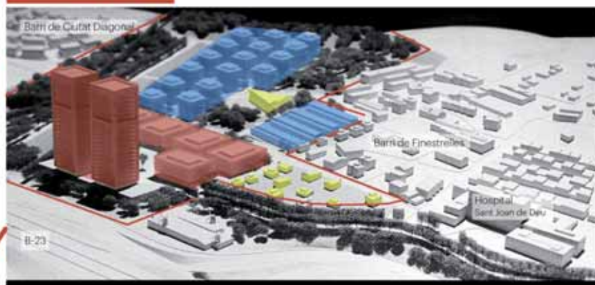
vista del sector nord
