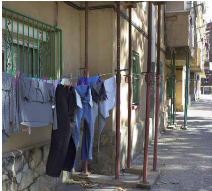
Edificis afectats per aluminosis al cor de la Trinitat Nova / ESTER MORA
