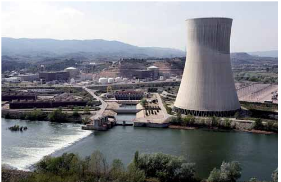
Xemeneia de la torre refrigeradora de la central d'Ascó, al meandre del riu Ebre / ARXIU
