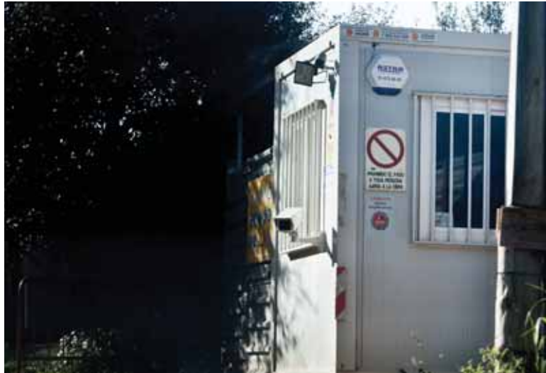
Les obres estan vigilades 24 hores al dia per diversos guàrdies i càmeres / C. P.
