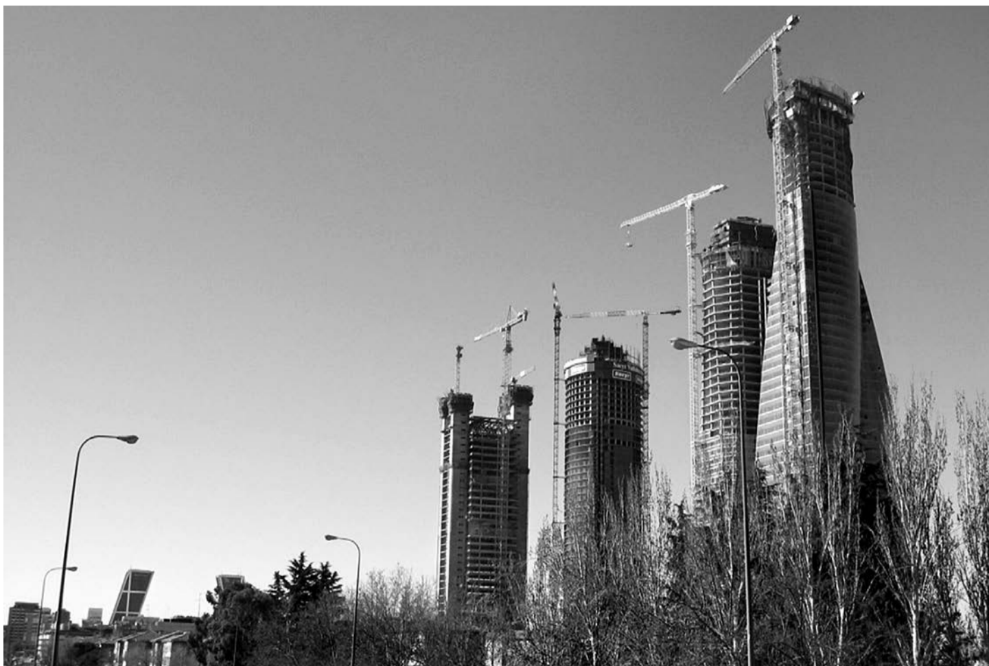
Construcció de les quatre torres, a Madrid
