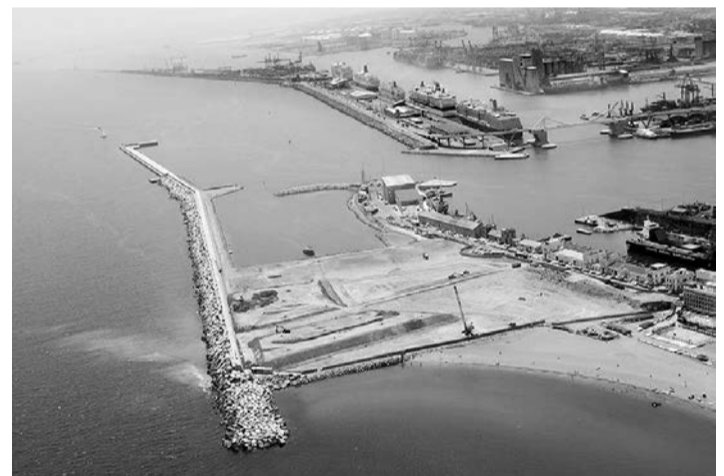
Terrenys guanyats al mar. Per construir l'anomenat Hotel Vela s'ha hagut de crear una plataforma artificial de sis hectàrees guanyades al mar. A la imatge es veu l'estat de les obres ara fa dos anys, just al límit de la platja de la Barceloneta.
