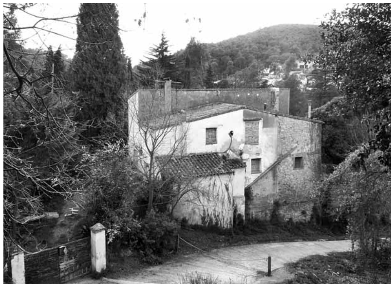
Seqüència de l'enderroc de Can Pujades i prat on s'hi ha abocat la runa (a sota a la dreta)
