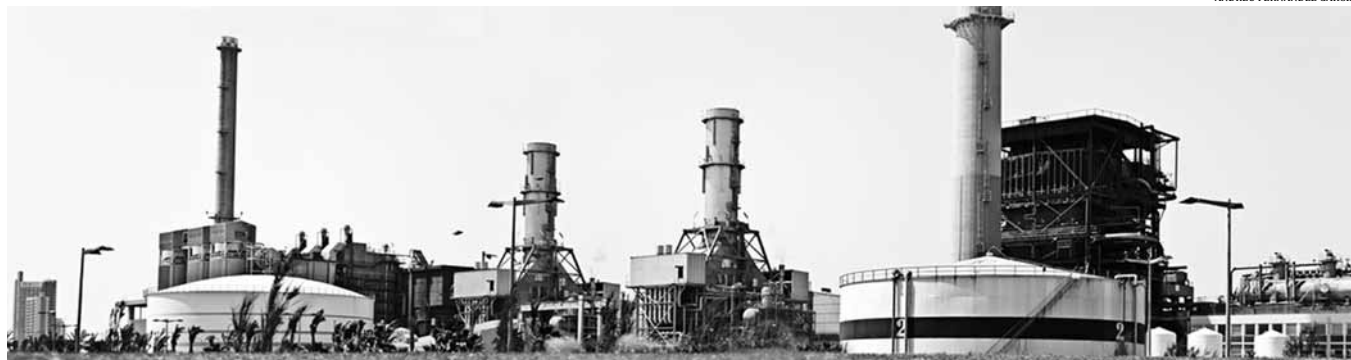
Incineradora de Sant Adrià de Besòs
