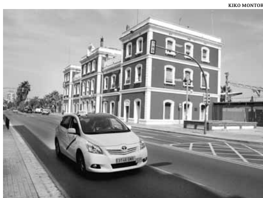
Estació de la RENFE de Mataró
