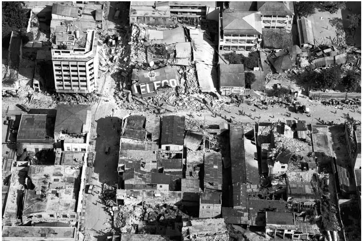
Panoràmica dels edificis del centre de la ciutat de Port-au-Prince arrassats per la força del terratrèmol
