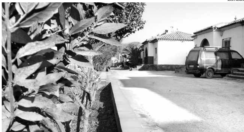
Les plantes que hi ha al voltant de les cases properes a Cementos Molins presenten una capa gruixuda de ciment
