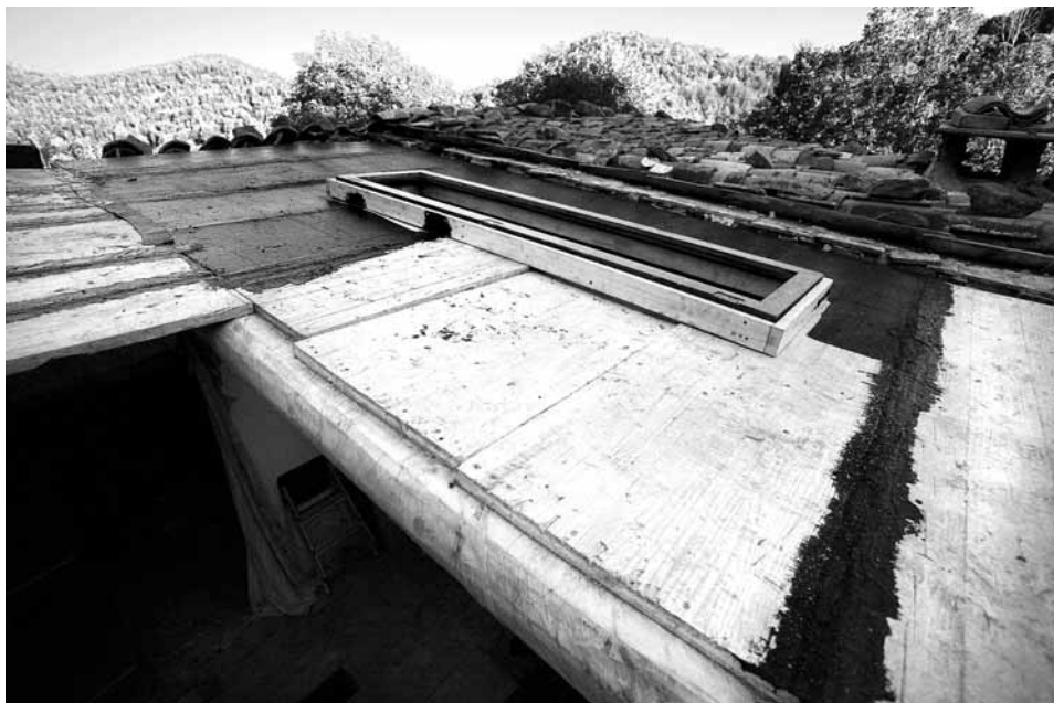
Rehabilitació d'una part de la teulada d'una masia del Ripollès
