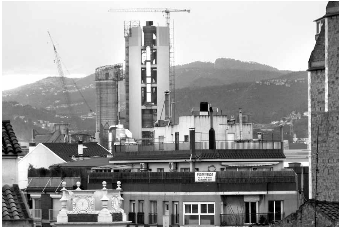
Aspecte de la torre de cícions de Cementos Molins vista des del pont que porta al poliesportiu de Molins de Rei, a dos quilòmetres de la fàbrica
