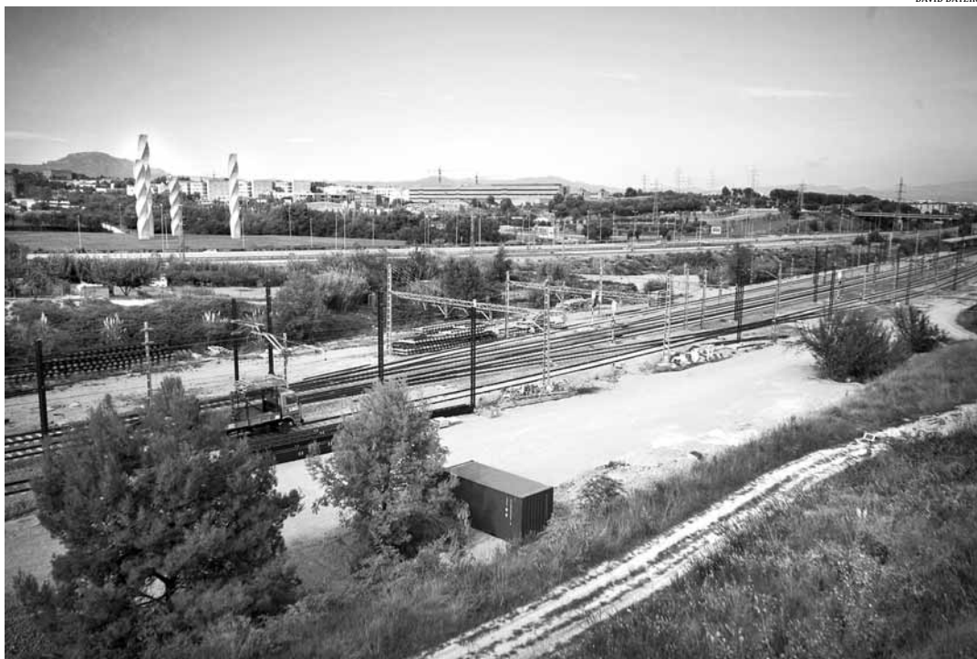
Indret on es va produir l'incident del 12 de gener, al quilòmetre 22 de la línia ferroviària de RENFE, entre les estacions de Mollet i Cerdanyola-UAB
