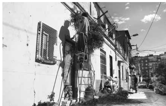
Rehabilitació de dues façanes del passatge Barnola
