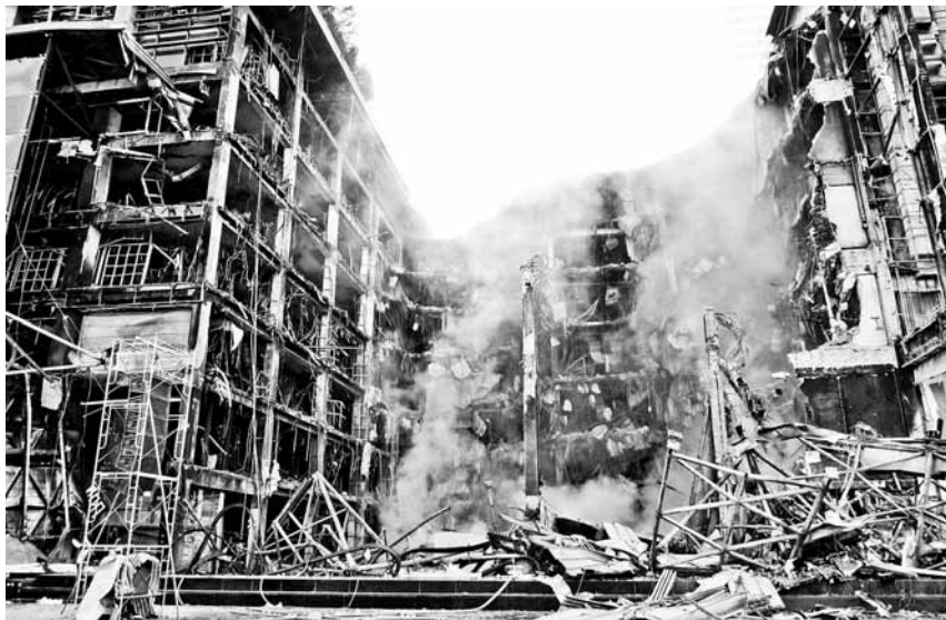
Les feines per extingir l'incendi que va afectar l'edifici Central World de Bangkok s'allarguen durant més de 20 hores
