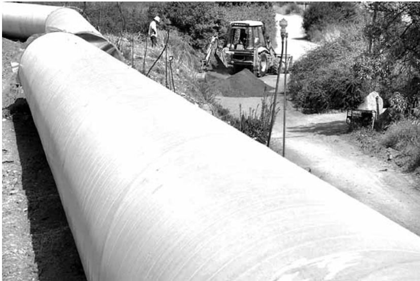
Aquest tub ha de portar aigua marina des de Blanes fins a Cardedeu i, des d'aquesta ciutat, es farà arribar a Barcelona.
