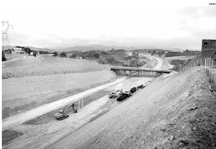
Habitualment, l'emissió de deute públic està vinculada a la construcció de grans infraestructures com el Quart Cinturó
