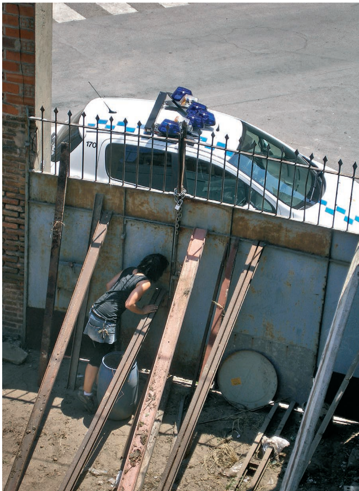
Apuntalament a l'interior del taller de bicicletes d'Hospitalet de Llobregat, desallotjat l'endemà.
