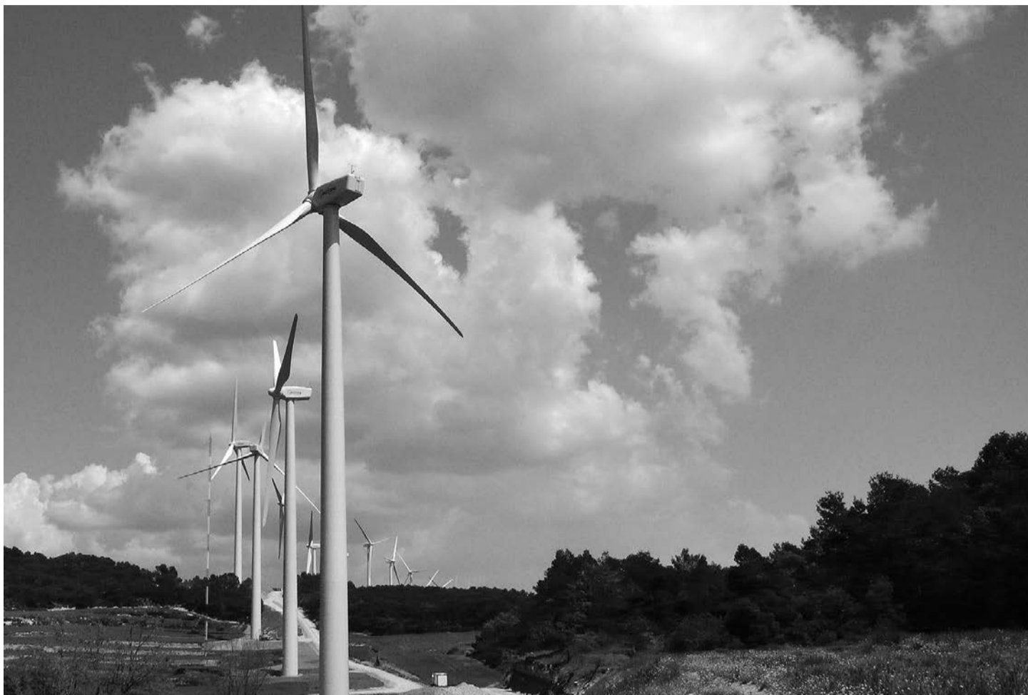
Central eòlica a la Serra del Tallat, la primera que es va construir a la Conca de Barberà
