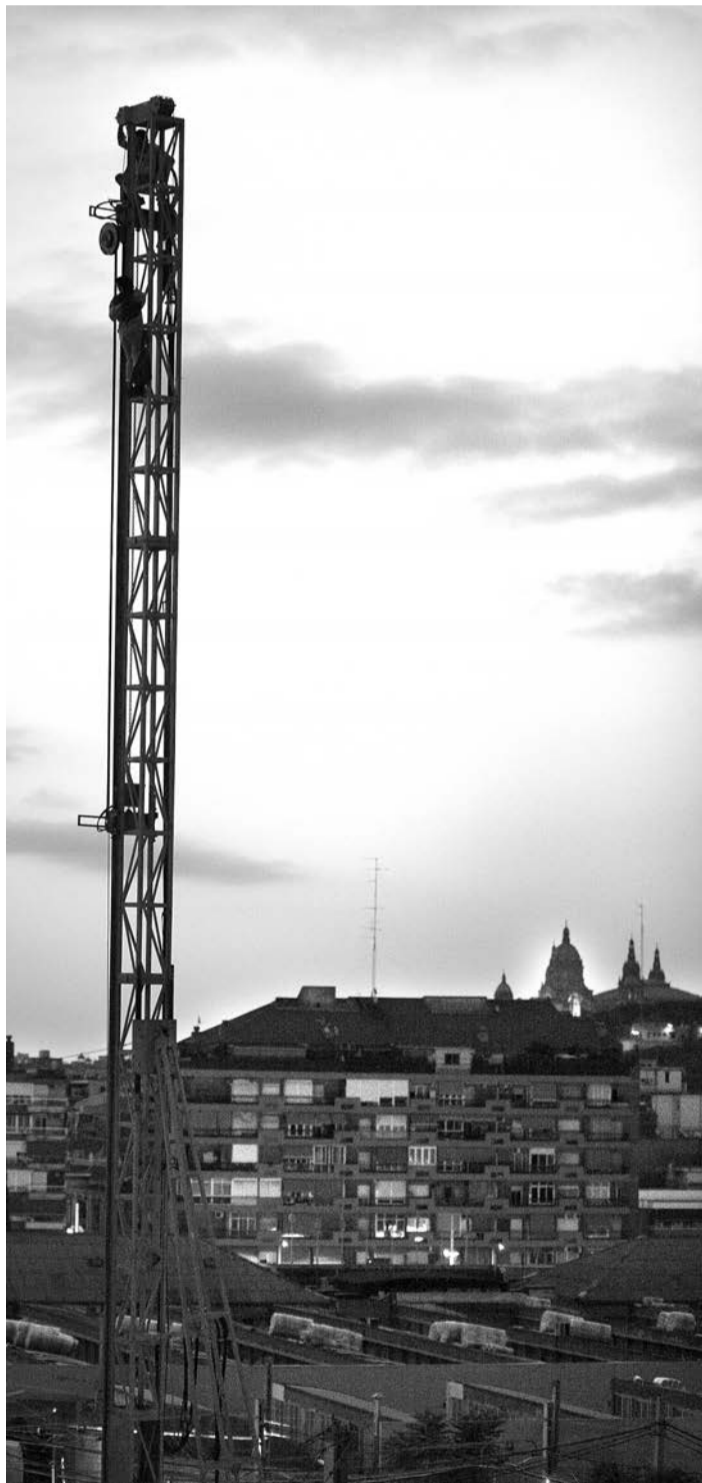
La grua més gran arribava als 30 metres d'alçada
