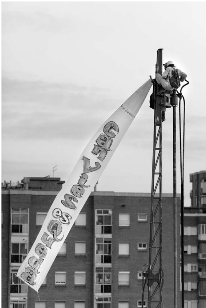
L'extrem superior d'aquesta grua es va tallar amb una serra radial per tal de treure els encadenats.
