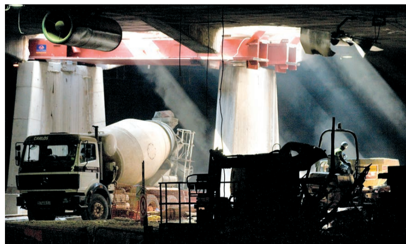
Obres del TAV a Sants-Estació, on es solapen totes les tasques
