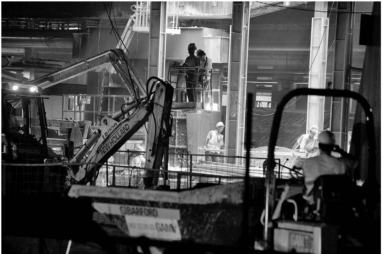
Obres del TAV al barri barceloní de Sants
