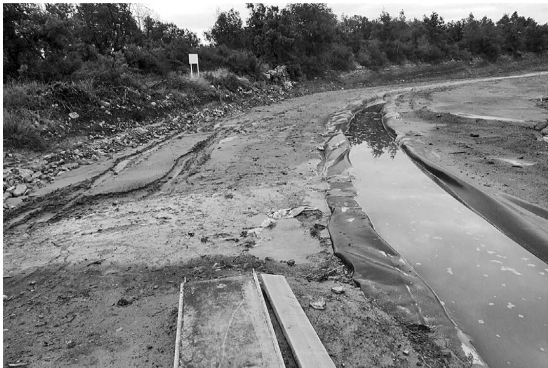
El vessament sobrepasa la canalització que pretén aïllar els abocaments salins
