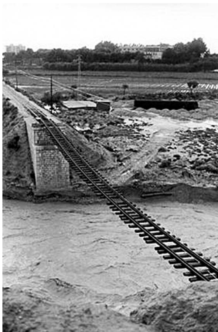
A la imatge de l'esquerra podem veure el barranc de l'Infern, indret on es va iniciar l'enorme rambla d'aigua que va escombrar tota la vall del riu Girona. A la dreta, efecte de la riuada sobre la línia ferroviària del Campello l'any 1987.
