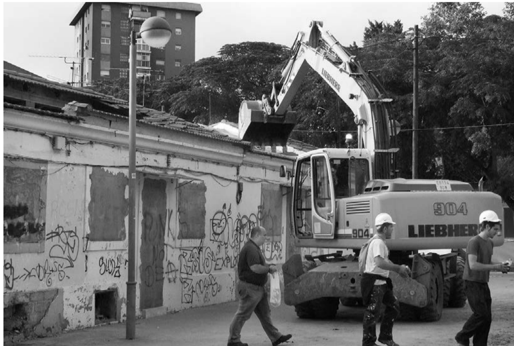
A la tarda començava l'enderroc d'aquestes cases barates construïdes el 1929
