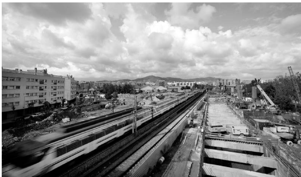
Obres de l'AVE a l'alçada de Bellvitge
