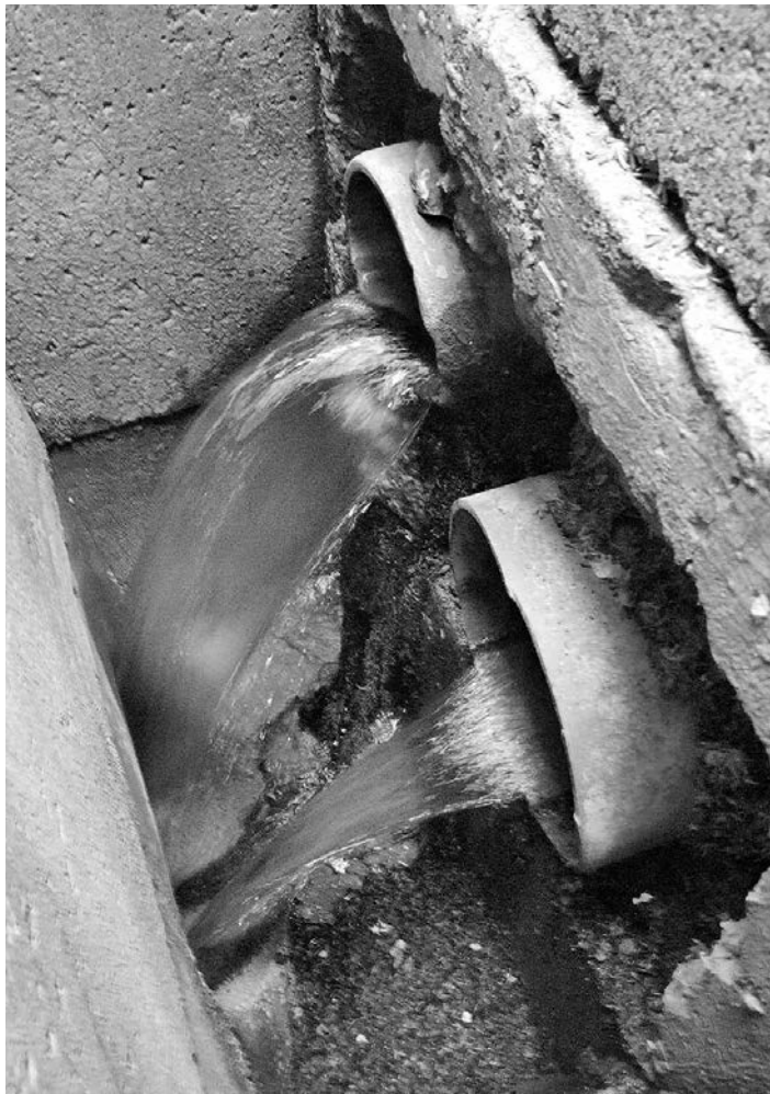
Abocament al costat de la seu d'Agbar (Barcelona)
