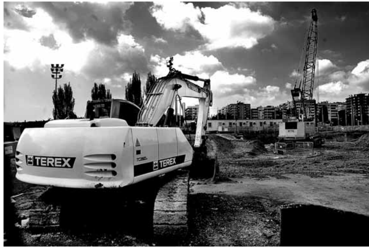
Grua de les obres de la línia 9 a la zona universitària de Barcelona
