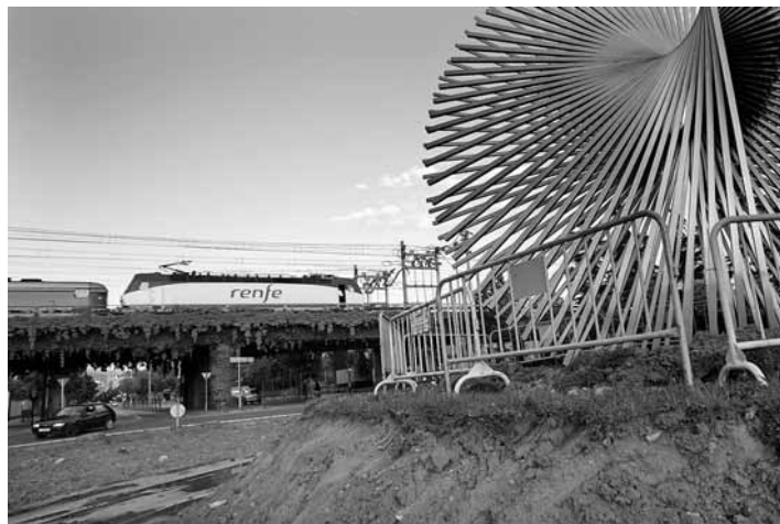
Començament de les obres que faran passar el TAV per la ciutat de Girona
