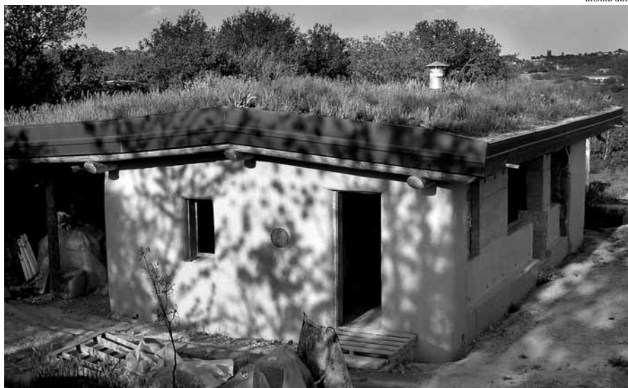
El Mas Luerna, casa de palla amb coberta vegetal, arrebossada amb argila
