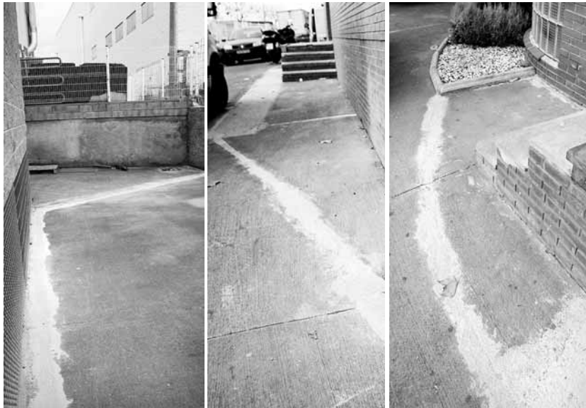
Llarg recorregut de la canonada soterrada per on s'extreu il·legalment l'aigua de pou
