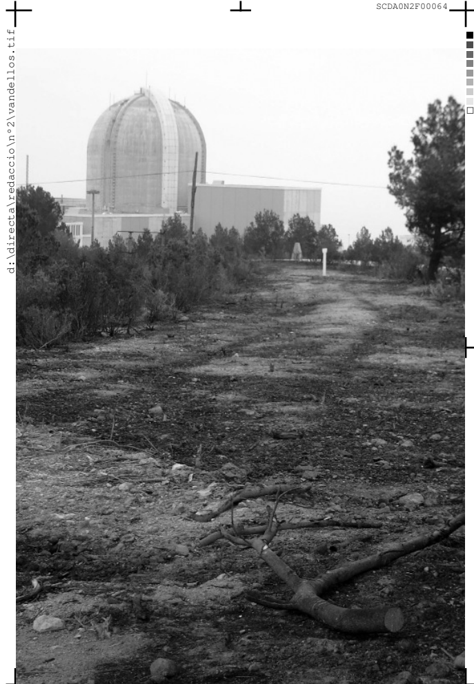
Les tanques del perímetre exterior de la central nuclear de Vandellòs van haver de ser remullades per evitar que les flames afectessin l'infraestructura energètica
