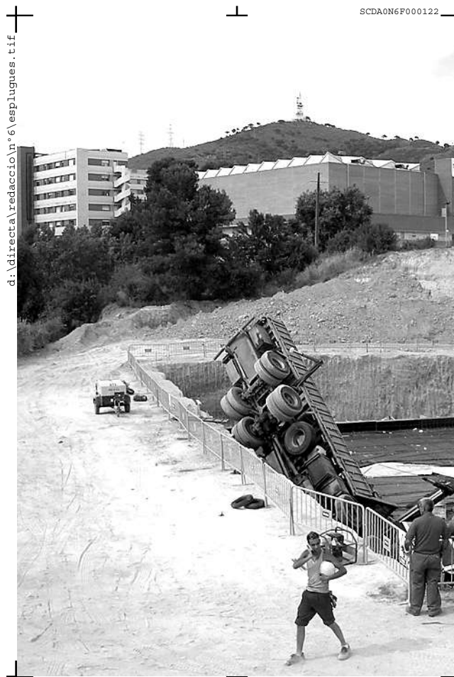
Un camió va caure als fonaments de les obres de construcció de la nova comisaria dels mossos d'Esplugues
