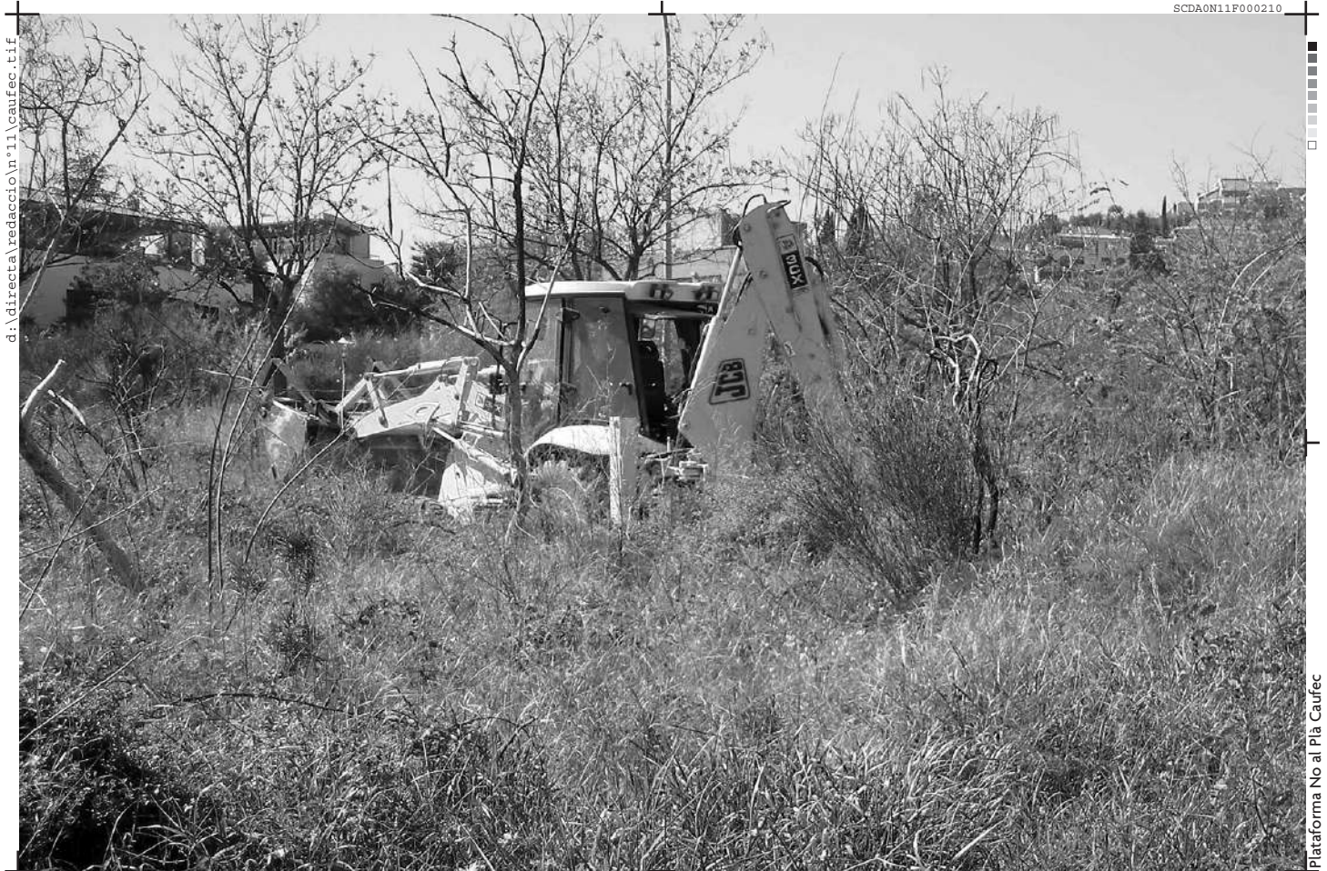
El 10 d'abril, una retroexcavadora entra al sector nord del Pla Caufec per obrir camins pels treballs topogràfics
