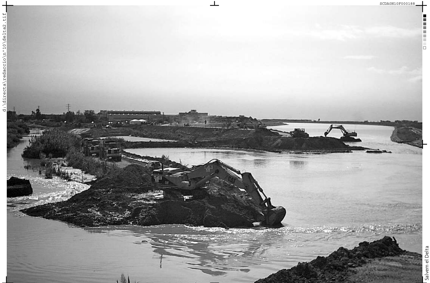
Obres de desviació del traçat natural del riu Llobregat
