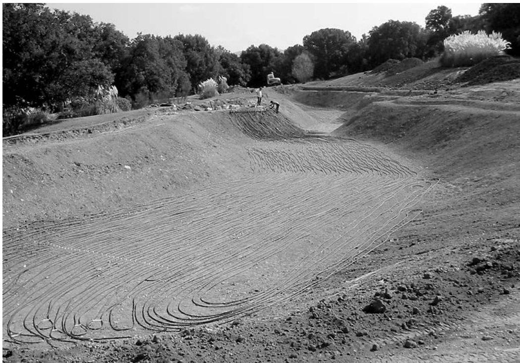
Bassa de purins del Baix Empordà, la calor de la qual s'aprofita per a produir energia
