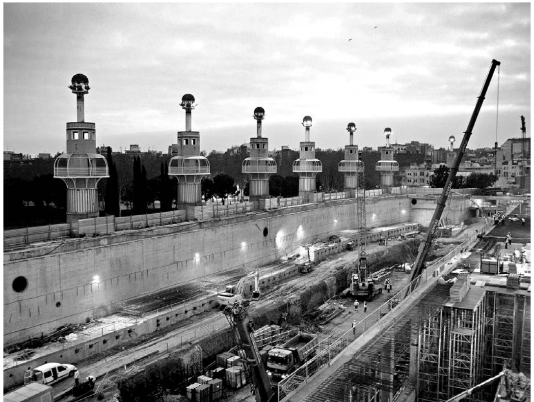
Les obres del TAV a la seva entrada al barri de Sants
