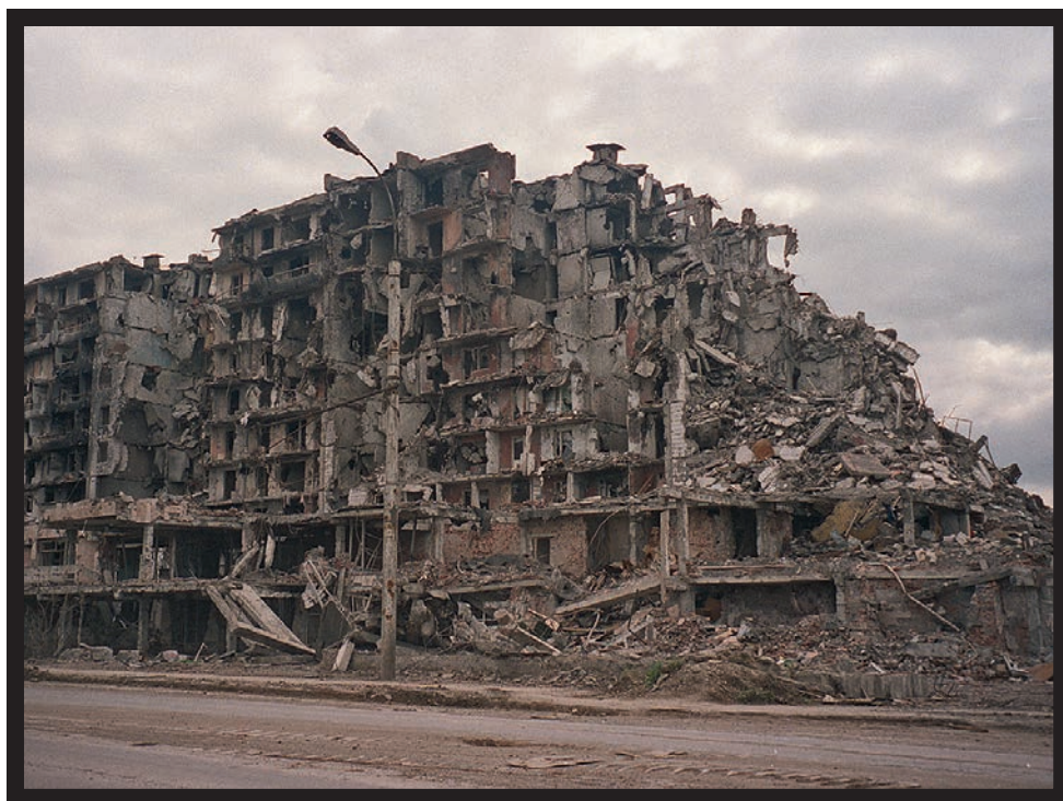
Habitatges destruïts al centre de Grozni
