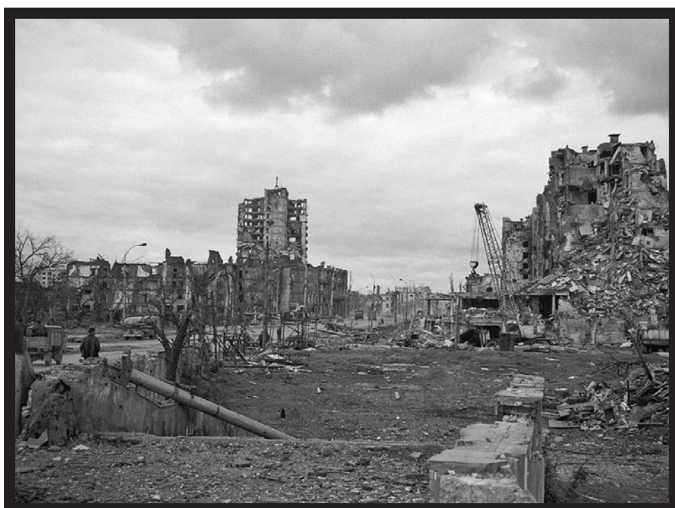
Habitatges destruïts al centre de Grozni
