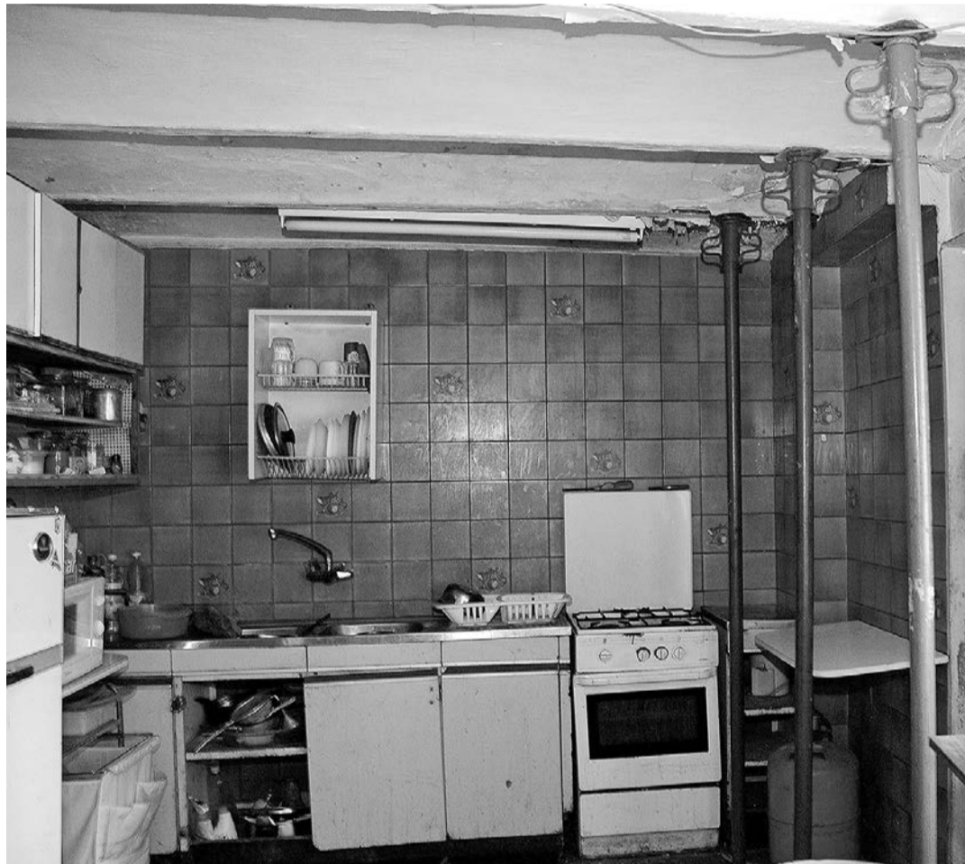
A la cuina, tres puntals a la cuina asseguren que no s'esfondri el sostre
