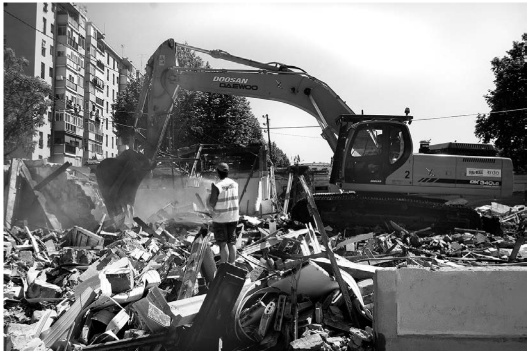
Les excavadores enderroquen les Cases Barates del Bon Pastor
