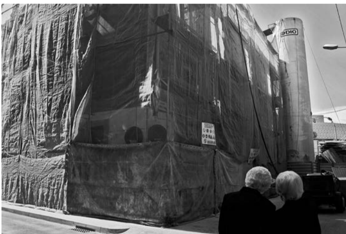
Edifici desallotjat per l'ajuntament al carrer Eusebi Planes i que ja ha començat a ser enderrocat.
